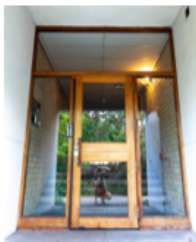
Entrépartierna i teak har vridskåps väll i de nedre glasfästena.
