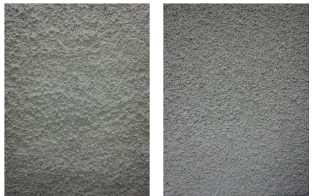
Handslagen puts till vänster och kompressorsprutad puts till höger.
