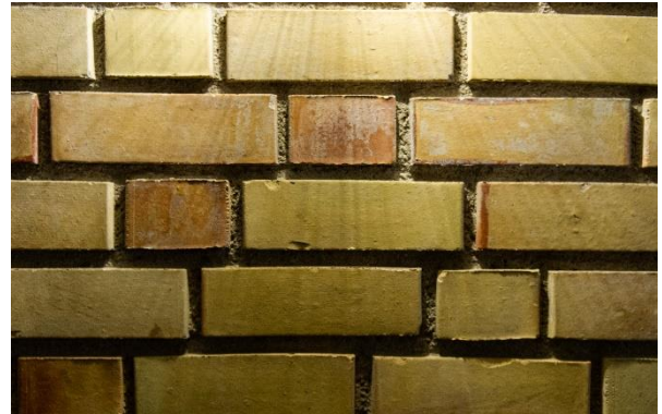
Tegel i korridorer med djupa fogar.
