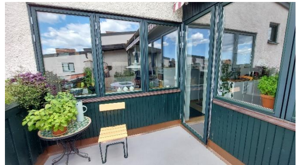
Fönsterband mot terrassen.
