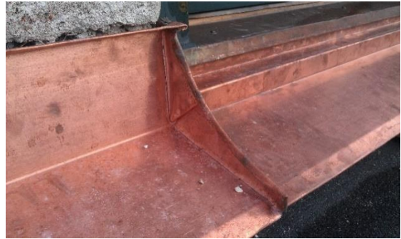
Plåtbeslag av koppar.
