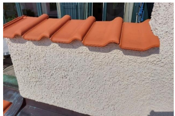
Kallmur med krön belagt med tegel.
