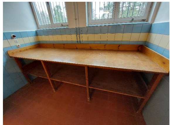
Ursprunglig inredning i tvättstugorna
