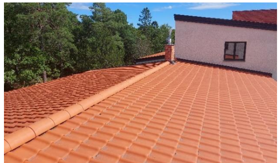
Tak med dubbelfalsat tegel.
